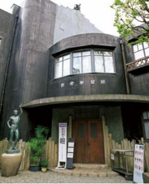
朝倉彫塑館入口。建物屋外にも朝倉の作品がある。
