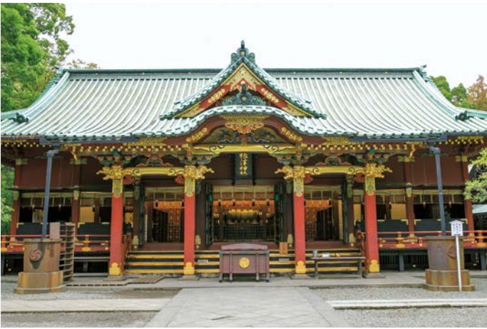
根津神社本殿の様子。
