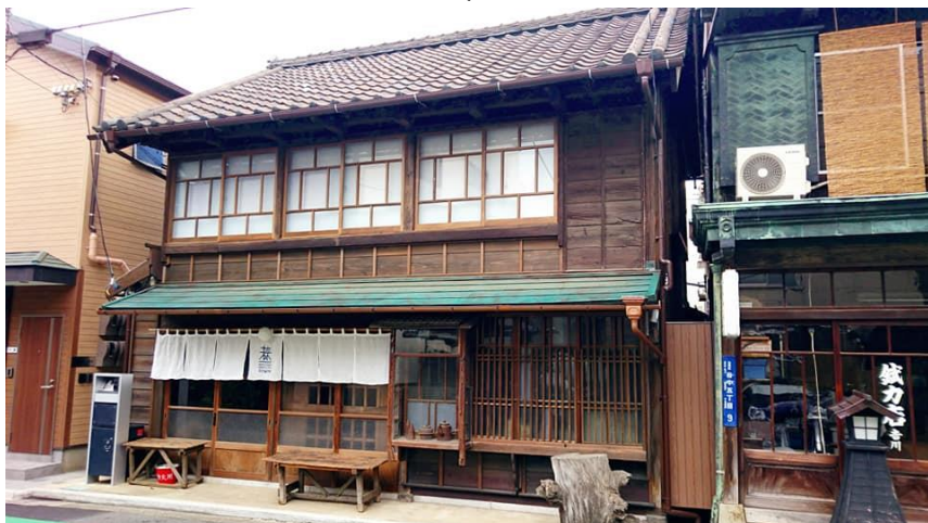
耐震補強を施し、ゆがみをとっ て再生。 大丸松坂屋百貨店の未来定番研 究所とした。
